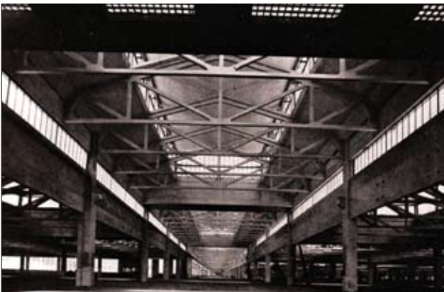
Fig. 5: Uso del vetrocemento nella copertura di un edificio dello Stabilimento Fiat a Mirafiori, Torino (da L'industria del vetro in Italia 1940).
