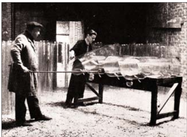
Fig. 2: Cilindri scalottati pronti per essere tagliati con il diamante dallo spaccalastre prima di passarli alla spianeria. Vetreria Bertolli & C., Pescia (da L'industria del vetro in Italia 1940 ).
