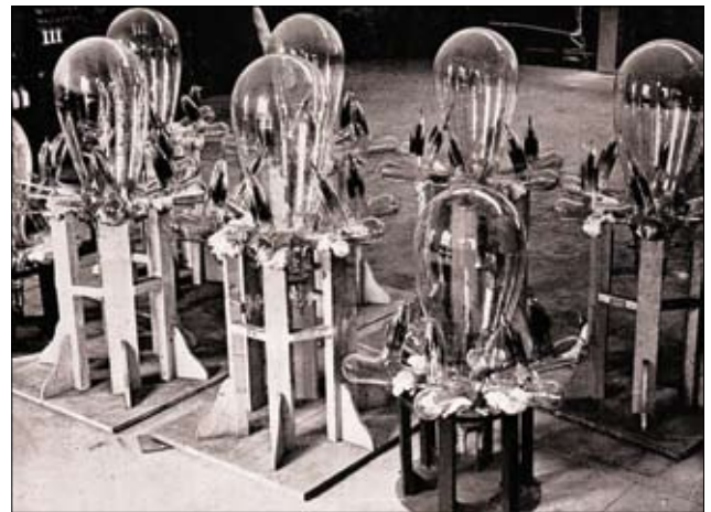
Fig. 13: Raddrizzatori di corrente a vapori di mercurio fabbricati dalla S. A. San Giorgio, Genova-Sestri, con ampole in vetro 'ignis' speciale prodotto dalla S. A. Cristalleria Murano, Milano (da L'industria del vetro in Italia 1940).
