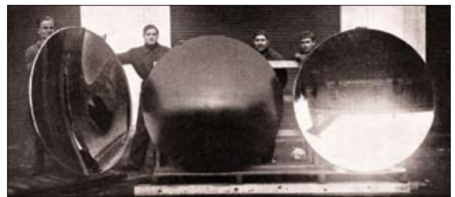
Fig. 14: Specchi parabolici per la Regia Marina realizzati dalla S. A. Giuseppe Maffioli, Porto Marghera, con cristalli della Fabbrica Pisana Saint Gobain (da L'industria del vetro in Italia 1940).
