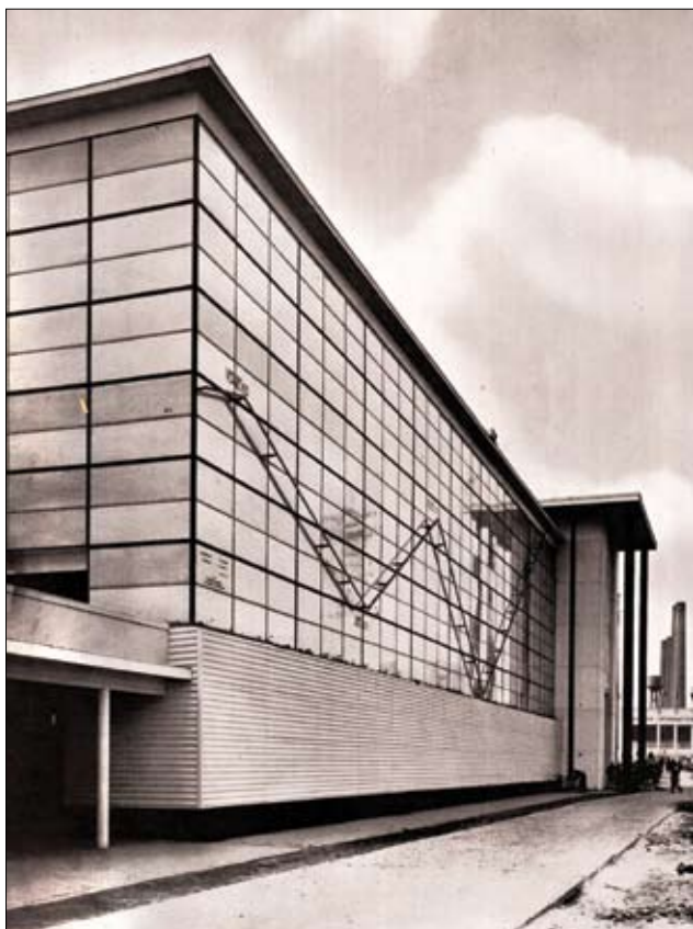
Fig. 8: Padiglione con pareti in vetro “termolux” della Vetreria Italiana Balzaretti Modigliani, Livorno. Liegi, Esposizione Internazionale, 1939 (da L’industria del vetro in Italia 1940).
