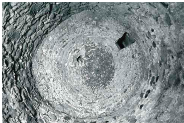
Fig. 1. Moncalieri (TO), Castello. Torre circolare ovest di facciata. La volta e la botola di scarico (da Paesi e Saporì 2005, p. 31).
