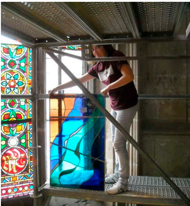
Fig. 4. Posa in opera di una vetrata nella Cattedrale di Maiorca.
